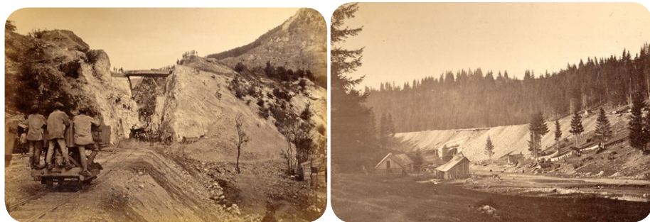
Obr. 1 – 2. budovanie zárezu (pri Ružíne) a násypu (pri Važci), 1871
