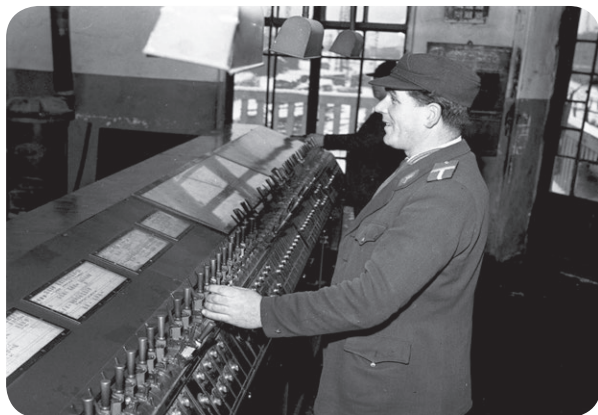
Obr. 6c elektropneumatiký stavadlový prístroj na stavadle IV v žel. stanici Žilina
