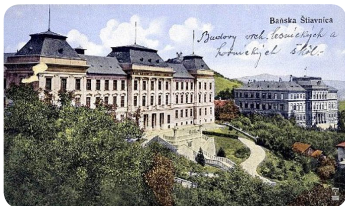
Obr. č. 3 - Budova Banskej akadémie, 1896, repro, I. Ladziarsky
