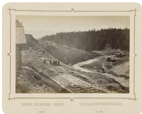
Košicko-bohumínska železnica počas výstavby - úsek pri obci Hybe, archív Múzea Spiša v SNV
