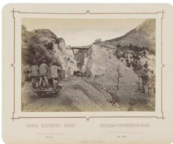
Košicko-bohumínska železnica počas výstavby - úsek pri niekdajšej obci Ružín, archív Múzea Spiša v SNV
