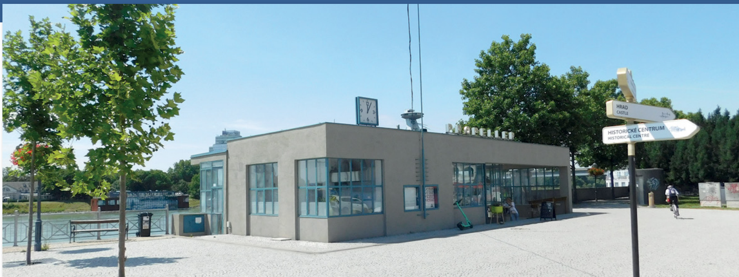
Obr. 18: Budova nástupišťa prievozu na bratislavskej strane Dunaja (pohľad zo severovýchodu) / Zdroj: Archív M. Goduša
