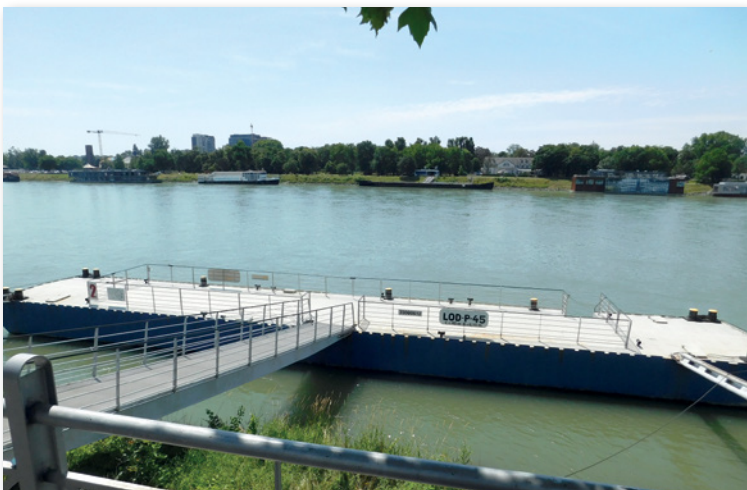
Obr. 21: Prístavný pontón s nástupovým mostíkom na ľavom brehu Dunaja Zdroj: Archív M. Goduša
