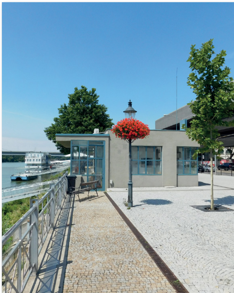
Obr. 24: Budova nástupištia prievozu na ľavom brehu Dunaja (pohľad z východu) / Zdroj: Archív M. Goduša
