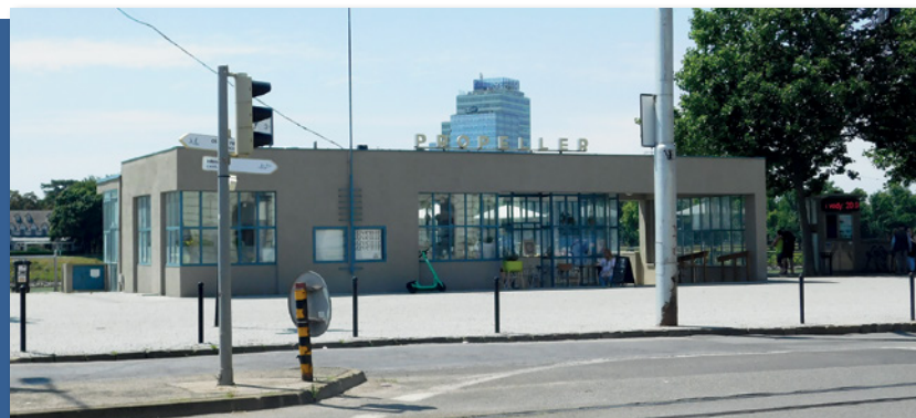
Obr. 17: Budova nástupišťa prievozu na bratislavskej strane Dunaja Zdroj: Archív M. Goduša
