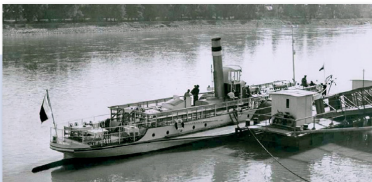
Obr. 7: Prístavný pontón z vyradeného dreveného člna, uchyteného o breh prostredníctvom šorpánu 22 , upevňovacieho trámu, nachádzajúci sa na petržalskej strane Dunaja, začiatok 20. storočia. Na pohľadnici je osobná loď POZSONY, neskoršia BRATISLAVA. / Zdroj: Archív J. Bohunského
