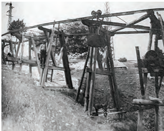
Drevená koľajnicová rampa lanovky Železník – Likier pred rokom 1894
