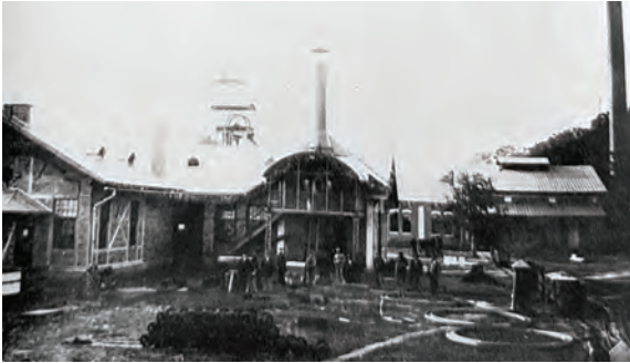
Povrchový areál Rákošskej Bane v roku 1903
