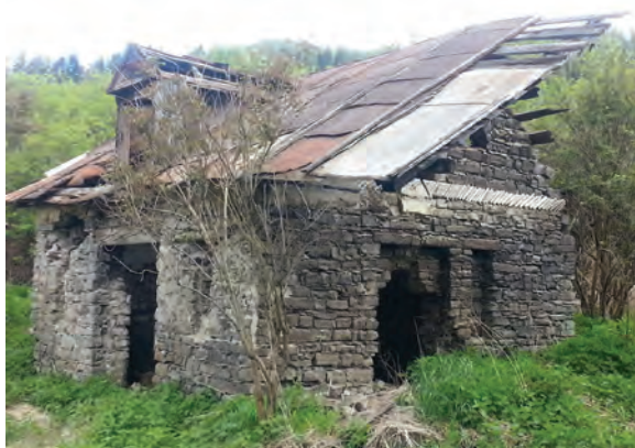
Valkovňa – pozostatky vyskej pece. Na ocelovom nosníku datovanie Rešica 1881 (rok 1993, rok 2017)
