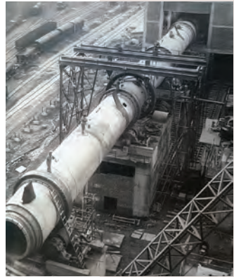
Výstavba rotačných pecí
