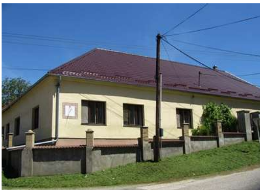
obr. 152 Slnečné hodiny sa nachádzajú na katolíckej fare v Uníne. Nápis na číselníku „BOH TI DÁVA ČAS“. autor foto: L. Barabás
