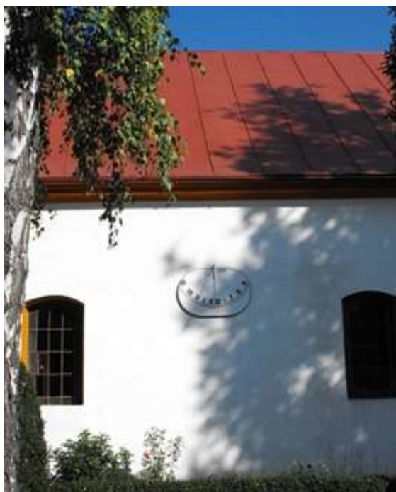
obr. 151 Turnianska Nová Ves, slnečné hodiny sú namaľované na doske z r. 2008 umiestnené v polovici steny kostolnej lode. Existovali tu aj skoršie, na východnej okraji steny lode, chátrali, až koncom 20. storočia zanikli a pri renovácii omietky ich na pôvodnom mieste neobnovili. autor foto: K. Pánik
