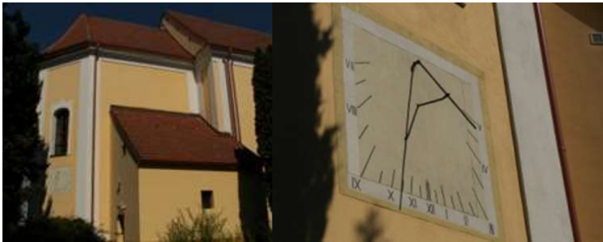
obr. 130 Stará Turá, južné vertikálne slnečné hodiny sú na katolíckom kostole z roku 1748. Majú pravouholníkový tvar, sú úplné a zrenovované. Ciferník je delený po celej hodine od siedmej hodiny rannej do piatej hodiny popoludňajšej. autor foto: M. Nosek
