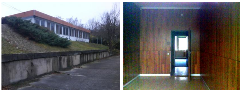
Obr. 5, 6 Opustená budova Slušovickej haly
