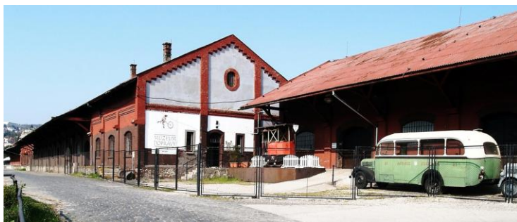
Obr. 14 Pohľad na časť skladu č. 1 a sklad č. 2 NKP stanice prvej parostrojnej železnice v Bratislave, Múzeum dopravy v daných objektoch bolo sprístupnené v roku 1999
