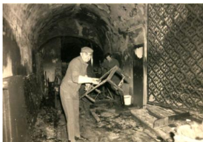
Obr. 1 Dôsledok požiaru v sídelnej budove STM 5. februára 1989
