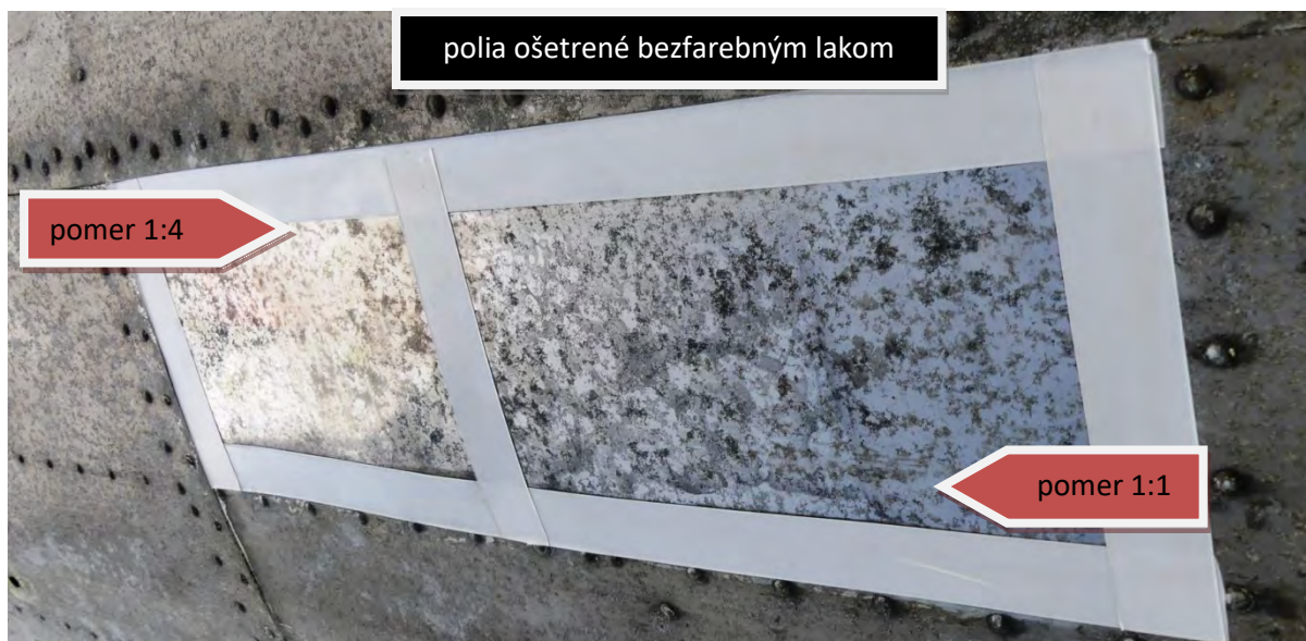
Obr. 95 - Celkový pohľad na finálne ošetrovanie potáhu s viditeľným rozdielom ošetrovaného a pôvodného potáhu
