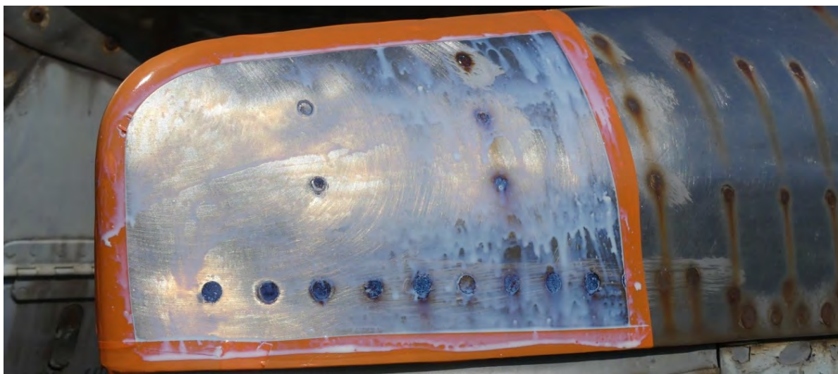
Obr. 113 - Aplikovanie inhibítora WÜRTH na plochu čela závesu
