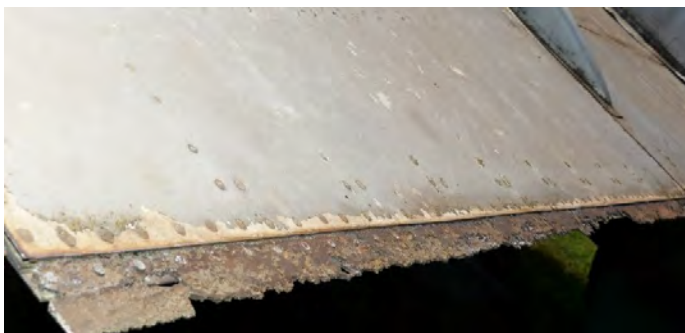
Obr. 34 - Odtoková hrana, strata materiálu
