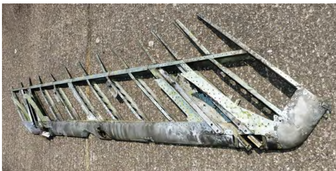
Obr. 32 - Klapka po odstránení poškodeného poťahu
