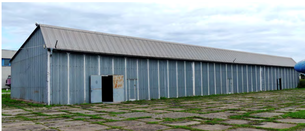
Obr. 3 - Prenosný oceľový hangár Picha 1922
