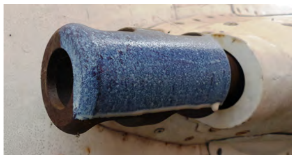
Obr. 132 - Aplikácia inhibítora a zatečenie
