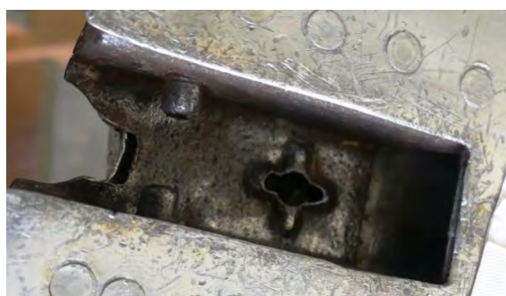
Obr. 248 - Odstránenie korózie na čistý kov
