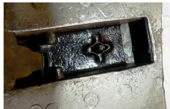
Obr. 250 - Ošetroenie ochranným lakom
