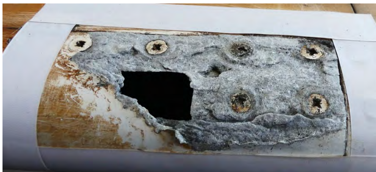
Obr. 149 - Vykonaná ochrana bezfarebným lakom vo forme aerosólu, následné zbelenie plochy
