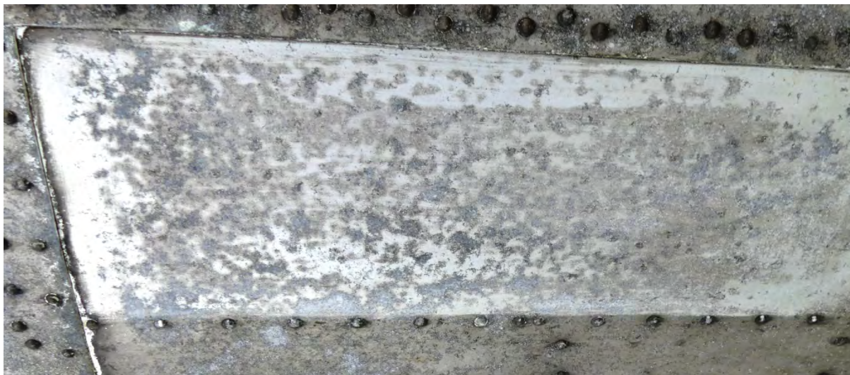
Obr. 100 - Pohľad na povrch potáhu po mechanickom odstránení korózie
