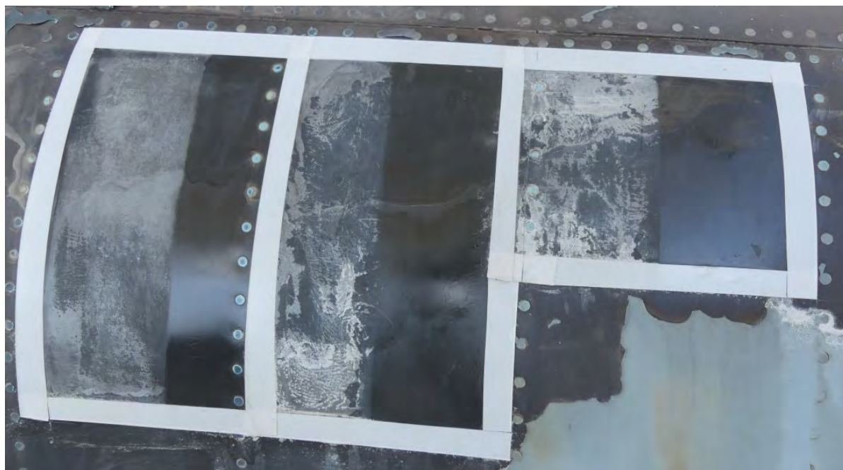
Obr. 216 - Vykonanie novej ochranej vrstvy
