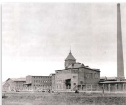
Nový solivar po výstavbe 1932 – JZ pohľad na areál
