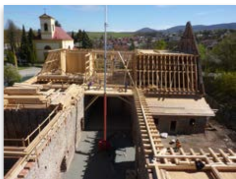
Sklad soli, obnova manzardovej strechy – replika pôvodnej
