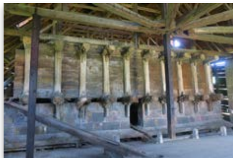
Četerne – interiér s poslednou dolnou nádržou na soľanku
