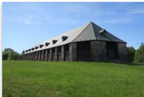
Četerne exteriér – máj 2022 pred obnovou
