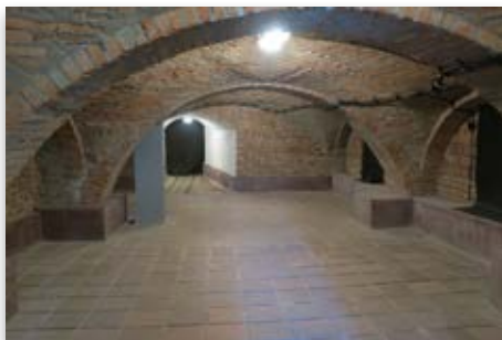
Varňa interiér – prízemie – máj 2022
