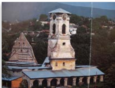
Sklad soli, zakonzervovaný objekt po požiaru bez manzardovej strechy
