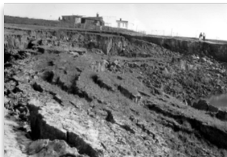
Obr. 2. Deformácia povrchu DP spôsobená prepadnutím nadložia v roku 1988
