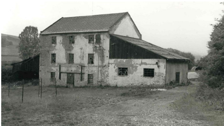
Obr. č. 4: Opustený niekdajší valcový mlyn Jozefa Cvangroša v Markušovciach v roku 1983. Autor: Š. Secha. Zdroj: PUSR
