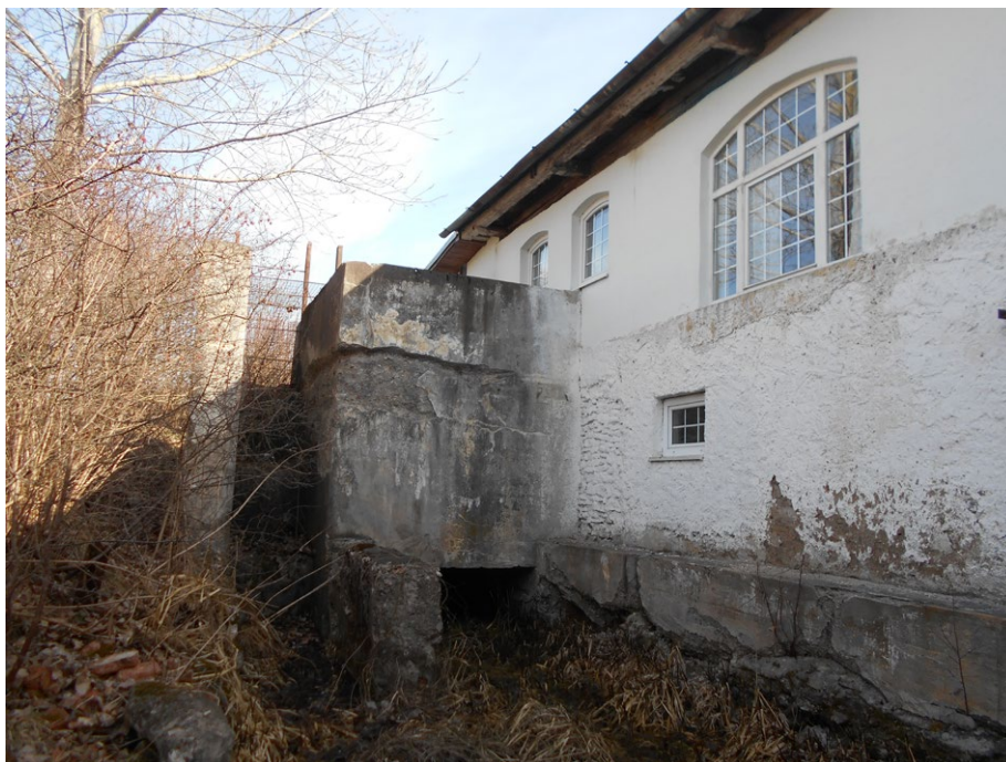
Obr. č. 10: Hrabušický starý mlyn s dodnes zachovanou turbínou v pôvodnej šachte. Zdroj: D. Patera, osobný archív.
