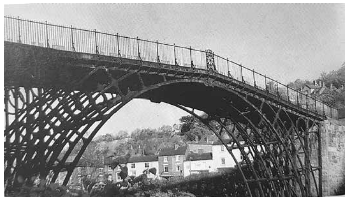
Darbyho liatinový most nad riekou Severn pri Coalbrookdale v Shropshire; mohutná železná konštrukcia je predimenzovaná
