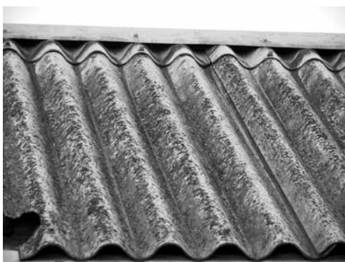
Strešná krytina z vlnitého eternitu
