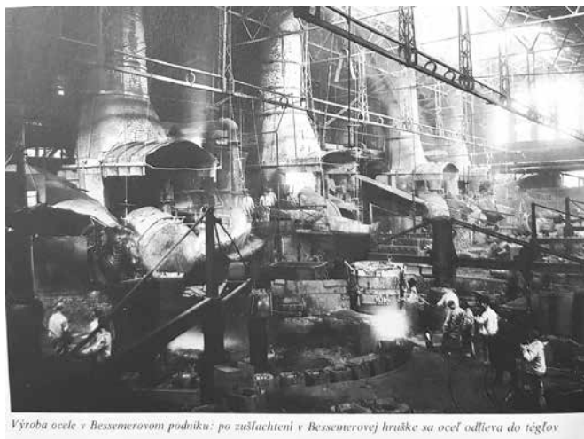
Výroba ocele v Bessemerovom podniku: po zušľachtení v Bessemerovej hruške sa oceľ odlieva do téglov
