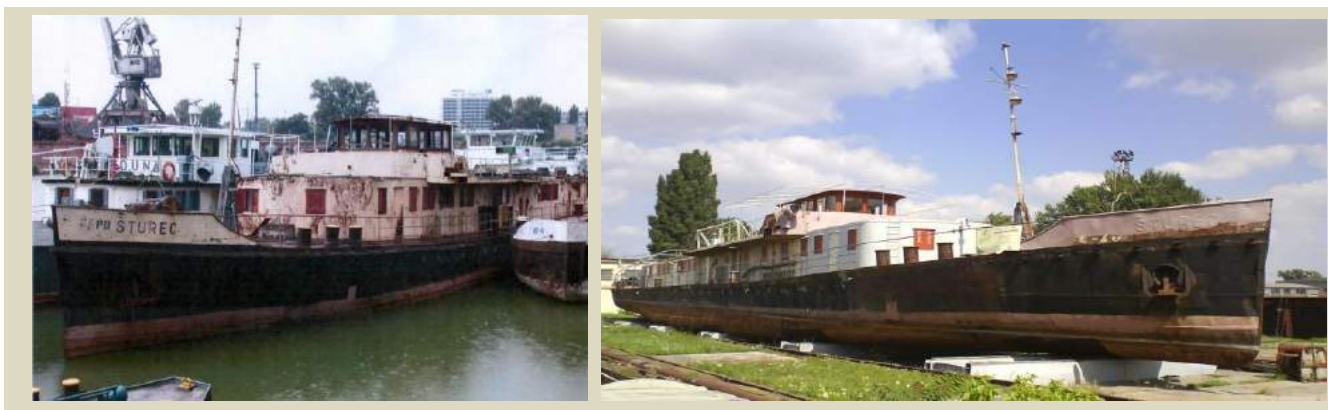
Remorkér Šturec stav v roku 2013 a stav v súčasnosti
